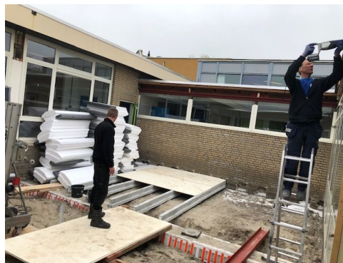
Vorbereidingen voor de overkapping
